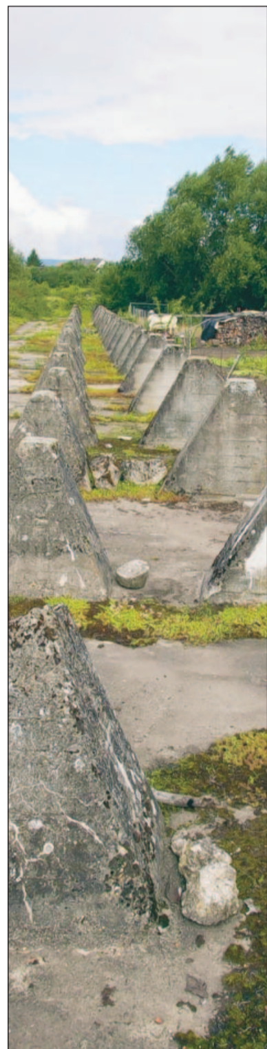
Eine Höckerlinie bei Steinfeld. Die Sperrwerke wurden kilometerweit im Viehstrich in Beton gegossen, um aus Frankreich vorrückende Panzer daran zu hindern, ins Deutsche Reich einzudringen.
