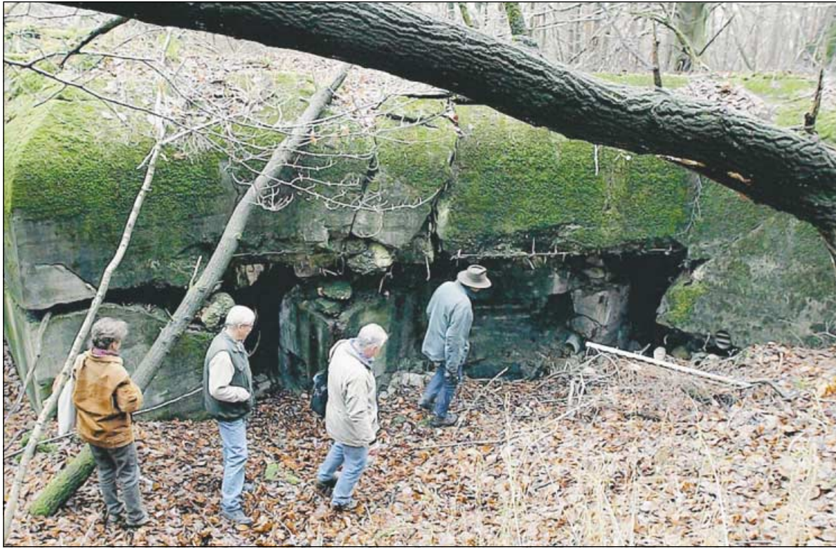
Eingehüllt in einen Mantel aus Moos und anderem Grün präsentiert sich dieser Bunker in der Nähe von Oberotterbach. Schon der Eingang zeugt von dem monumentalen Bauwerk. —FOTOS: THÜRING
