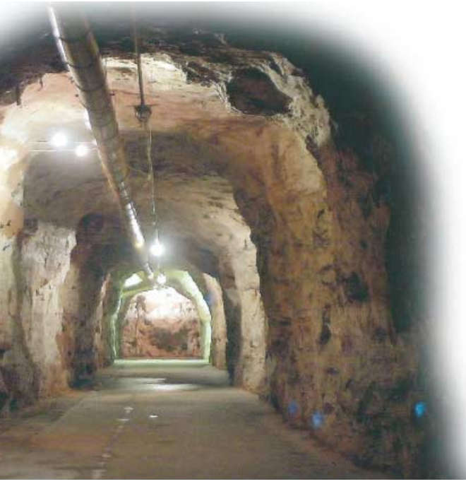
Einfahrt in die Unterwelt des Westwall-Museums von Niedersimten.
